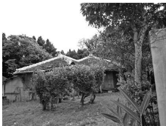
写真⑫ 空家となった古民家
