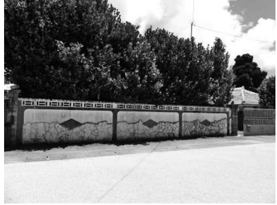
写真2 石張りのブロック塀と白い透水性舗装 景観修景の例
