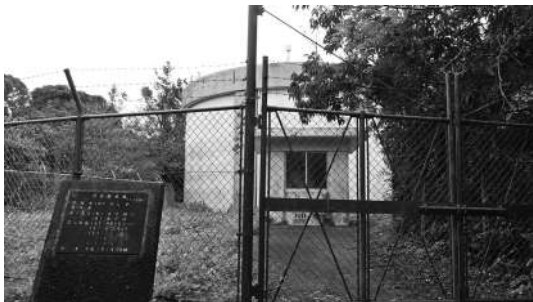
写真 58 瀬底配水池 平成4年竣工、容量2000m 3
