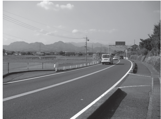
写真3 向山神社以北の国道156号 (関市下有知、図3中のF地点、筆者撮影)
