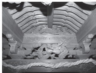
写真5 本殿軒唐破風妻飾
