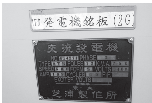
写真4 南小田第一発電所旧設備銘板
