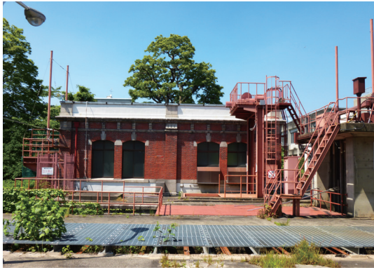
写真3 夷川発電所 (2014年5月8日岡田幸子撮影)
