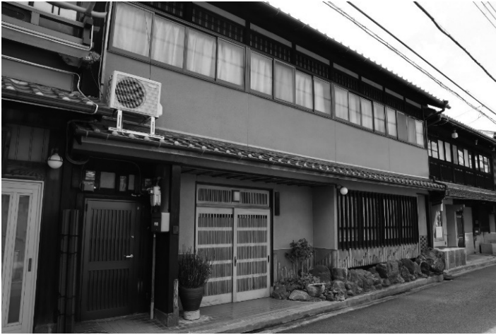
写真1 奥西家住宅（2021年6月14日撮影）
