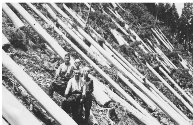
写真5 杉の伐採。眞谷。昭和25年（1950）3月。
