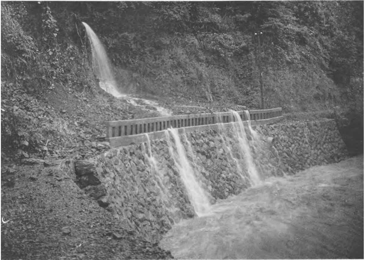
33. 昭和10年(1935)6月29日水害。道路上に土石が流れ込んだところ。すいのかみ付近。雲ヶ畑自治振興会所蔵。
