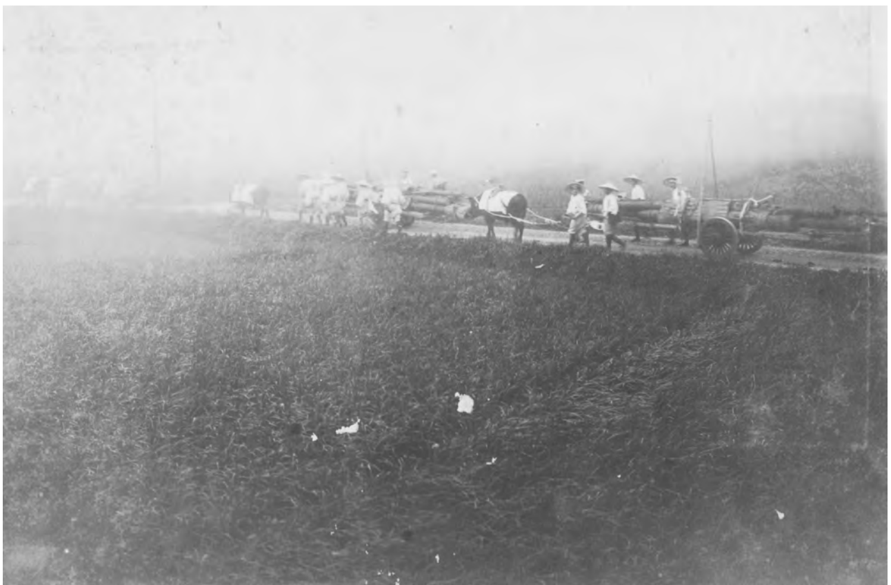
24. 御用材の運搬。上賀茂の柵野付近。昭和3年(1928)8月10日。波多野周造氏撮影。
